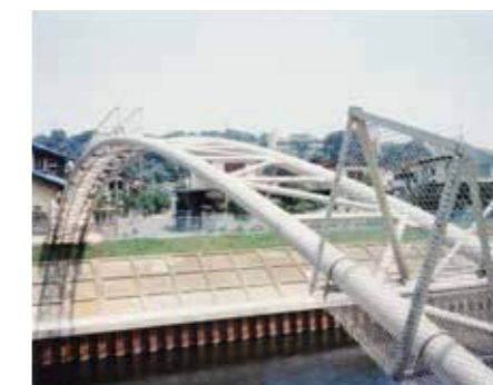
ステンレス水管橋 (ダブルアーチ型) Stainless steel pipe Aqueduct
